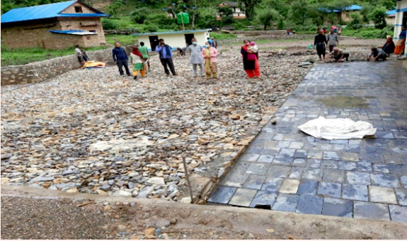
प्रधानमन्त्री रोजगार कार्यक्रमबाट वडा नं. ६ को कार्यालय परिसरमा सोलिङ तथा ढुङ्गा छाप्ने कार्य
