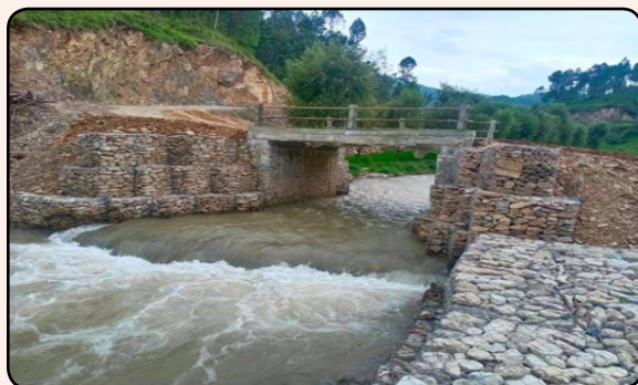
वडा नं. २ मा निर्माण गरिएको पक्की कल्भर्ट
