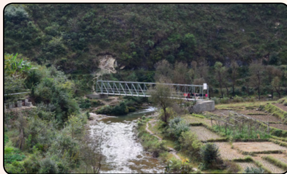
वडा नं. ५ मा निर्मित टुस पुल
