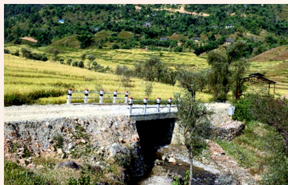
गाउँपालिकाद्वारा निर्माण गरिएको जुगार-ज्यूला खोला मोटरेवल कल्भर्ट
