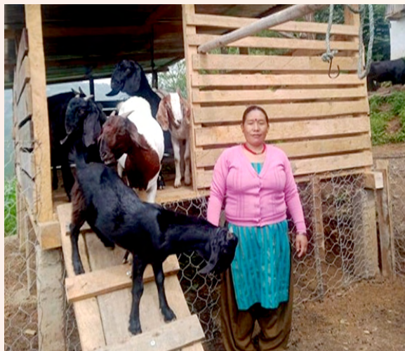
गाउँपालिका र कृषकको संयुक्त लगानीमा कृषकद्वारा निर्माण गरिएको बाख्रा खोर
