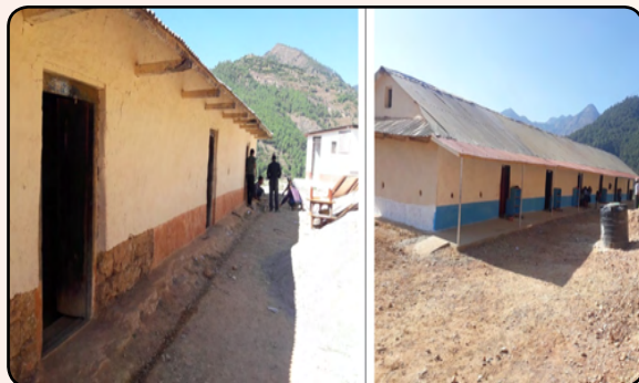
भानु आ.वि. बाँकबोटको विद्यालय भवन मर्मत
