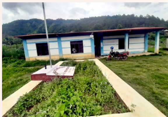
गाउँपालिकाबाट निर्माण गरिएको वडा नं. २ को कार्यालय भवन
