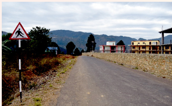
गाउँपालिकाद्वारा निर्मित जुगार-निगालपानी सडकको नव नेपाल क्याम्पस खण्ड कालोपत्रे
