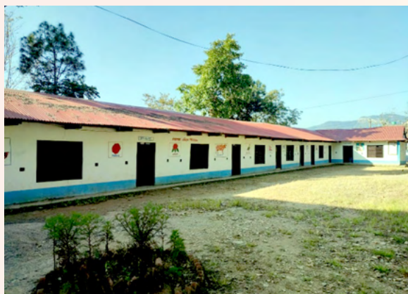
मुख्यमन्त्री ग्रामीण विकास तथा रोजगार कार्यक्रमबाट श्री जनजागृति मा.वि. जुगारको भवनको छानो फेरिएको भवन
