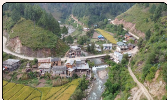
त्रिवेणी गाउँपालिका वडा नं. २ र ७ जोड्ने त्रिवेणी पुल
